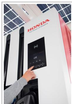
Honda betreibt in Offenbach eine öffentliche Ladesäule mit 940-V-Hochvolttechnologie, an der gleichzeitig bis zu vier Fahrzeuge mit unterschiedlichen Steckertypen aufgeladen werden können.
